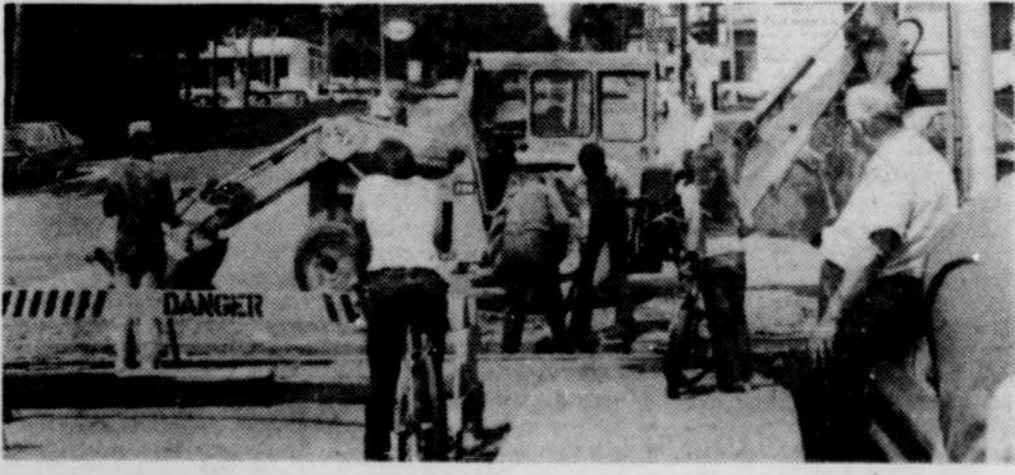
Un aperçu des travaux effectués par la ville. Ces travaux concernent la voie ferrée de la rue Merry sud. (Photo La Tribune, Fernand Boisvert)
