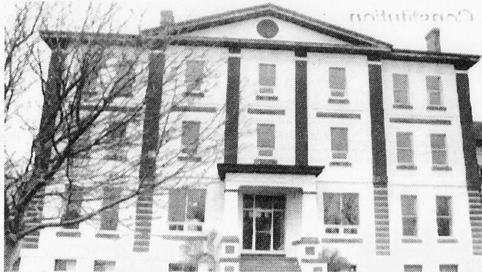
DEMOLITION - L'orphelinat du Mount Cashel sera démoli. Le terrain, une propriété de premier ordre dans le quartier nord-est de Saint-Jean, est évalué à 8 millions $.
