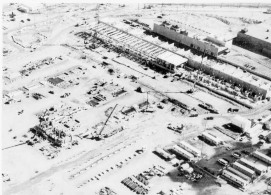
Vue aérienne du chantier du Projet AP60 Phase 1.
