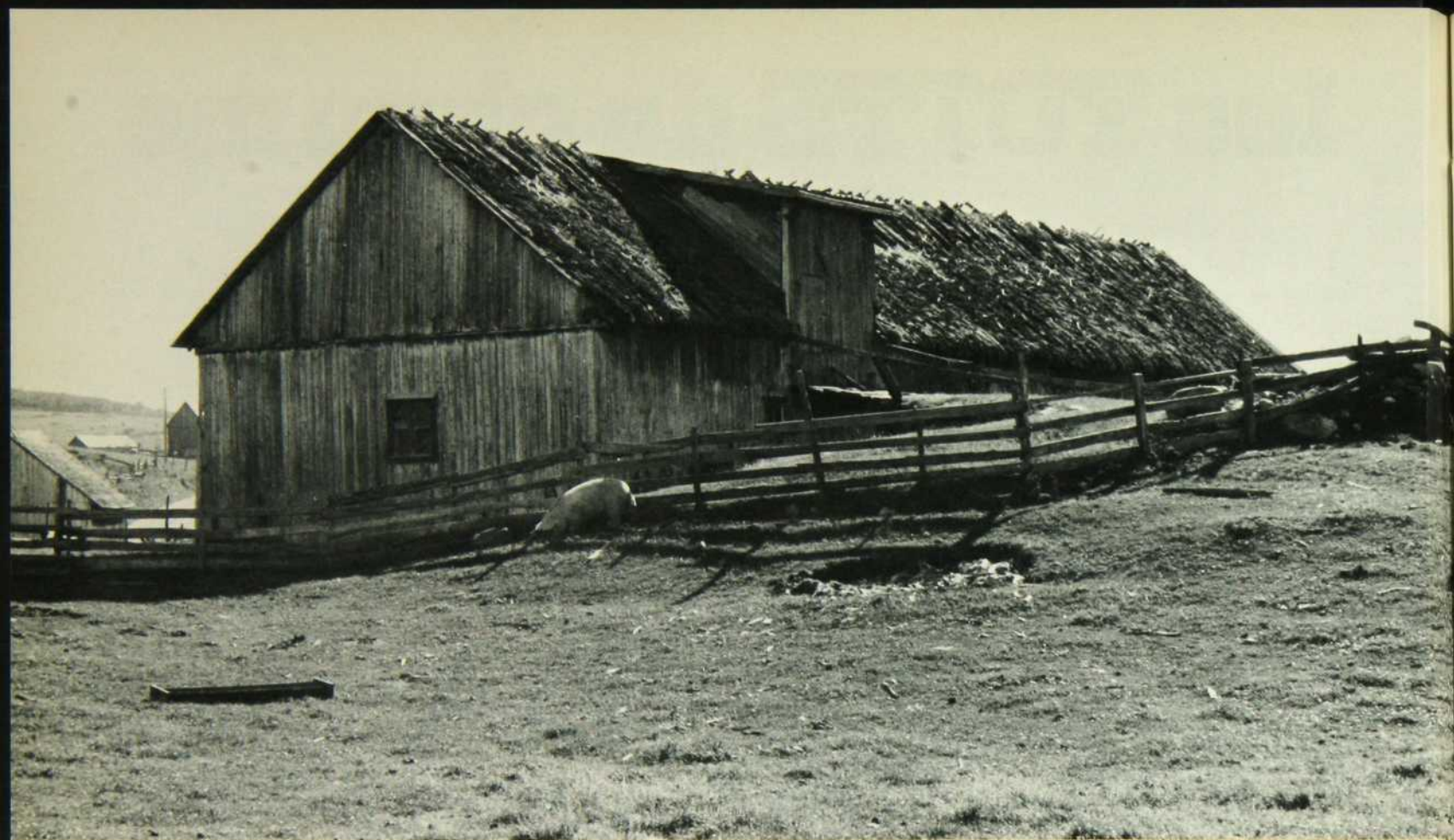
Grange à toit de chaume, dans le rang Saint-Jean-Baptiste à Saint-Urbain, comté de Charlevoix. Vue de près, les toits de chaume sont parsemés de moisissures ou de mousses vertes qui en font un matériau plutôt humide que sec (Photo: Yves Laframboise).
