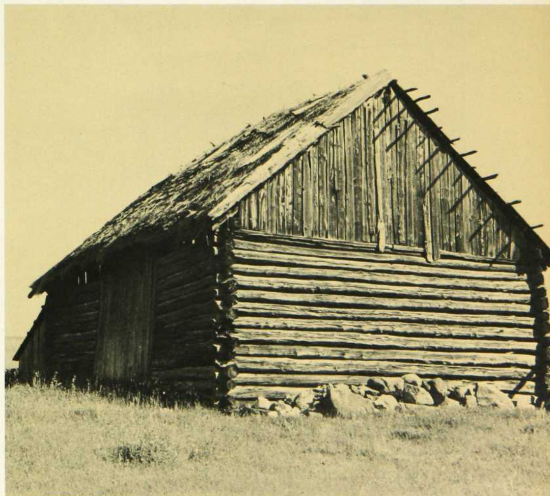
Détail de la précédente. Les "tringles" ou "traverses", auxquelles sont attachées les bottes de paille, excèdent le pignon.
