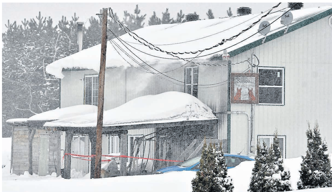
La Sûreté du Québec a ouvert une enquête concernant un incendie ayant légèrement endommagé cette maison de Notre-Dame-du-Mont-Carmel. — PHOTO: STÉPHANE LESSARD
