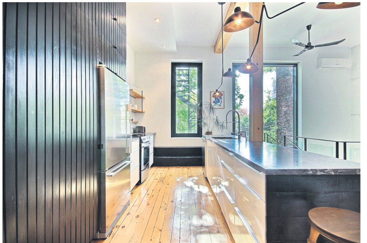
Le propriétaire a retiré des murs et a dû soutenir la structure au moyen de poutres en bois. Les lattes du lambris cachent des armoires et d'autres rangements.
