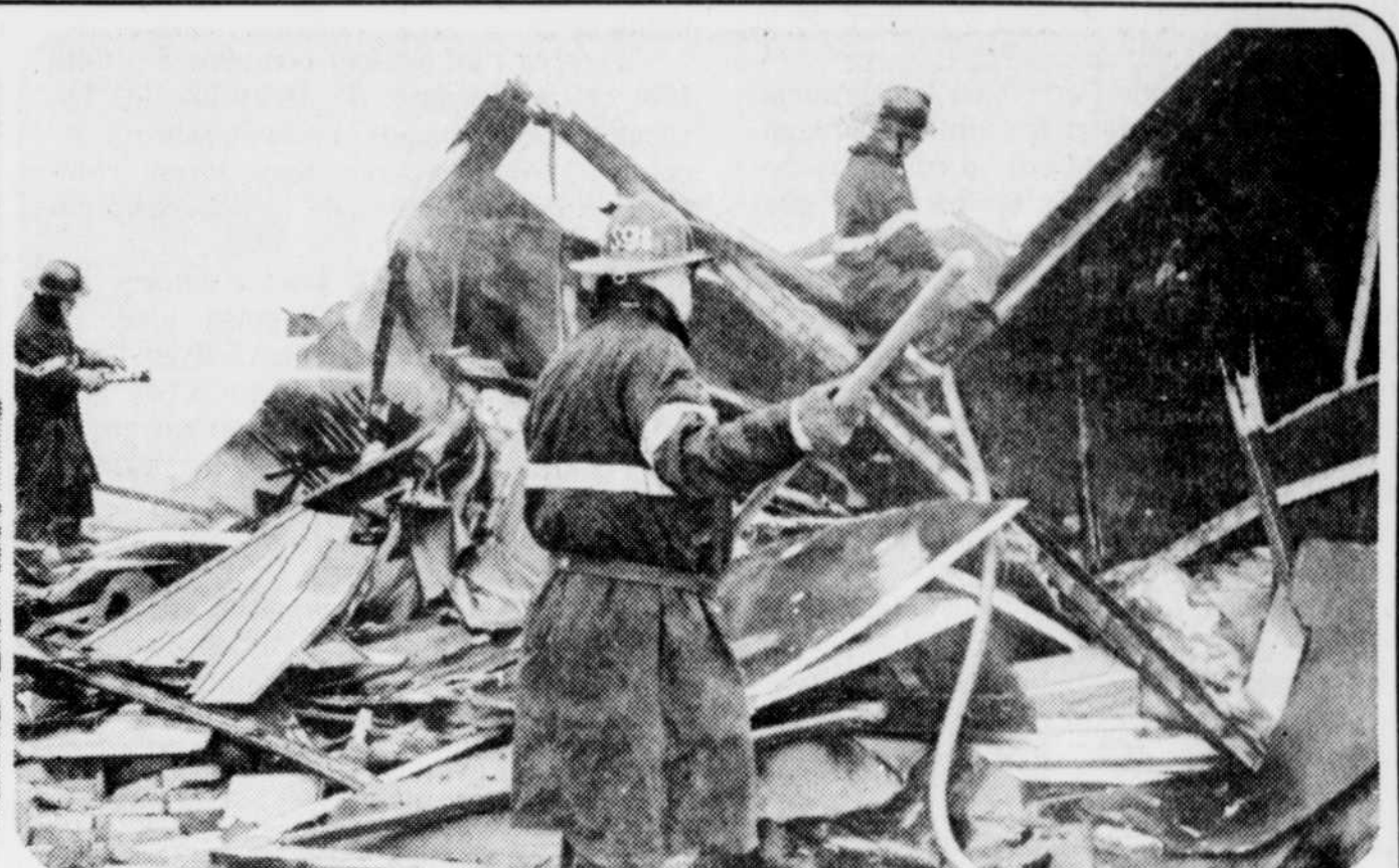
Une partie de l'immeuble abritant les quatre commerces détruits par un incendie samedi matin sur le boulevard des Forges s'est effondrée au cours
