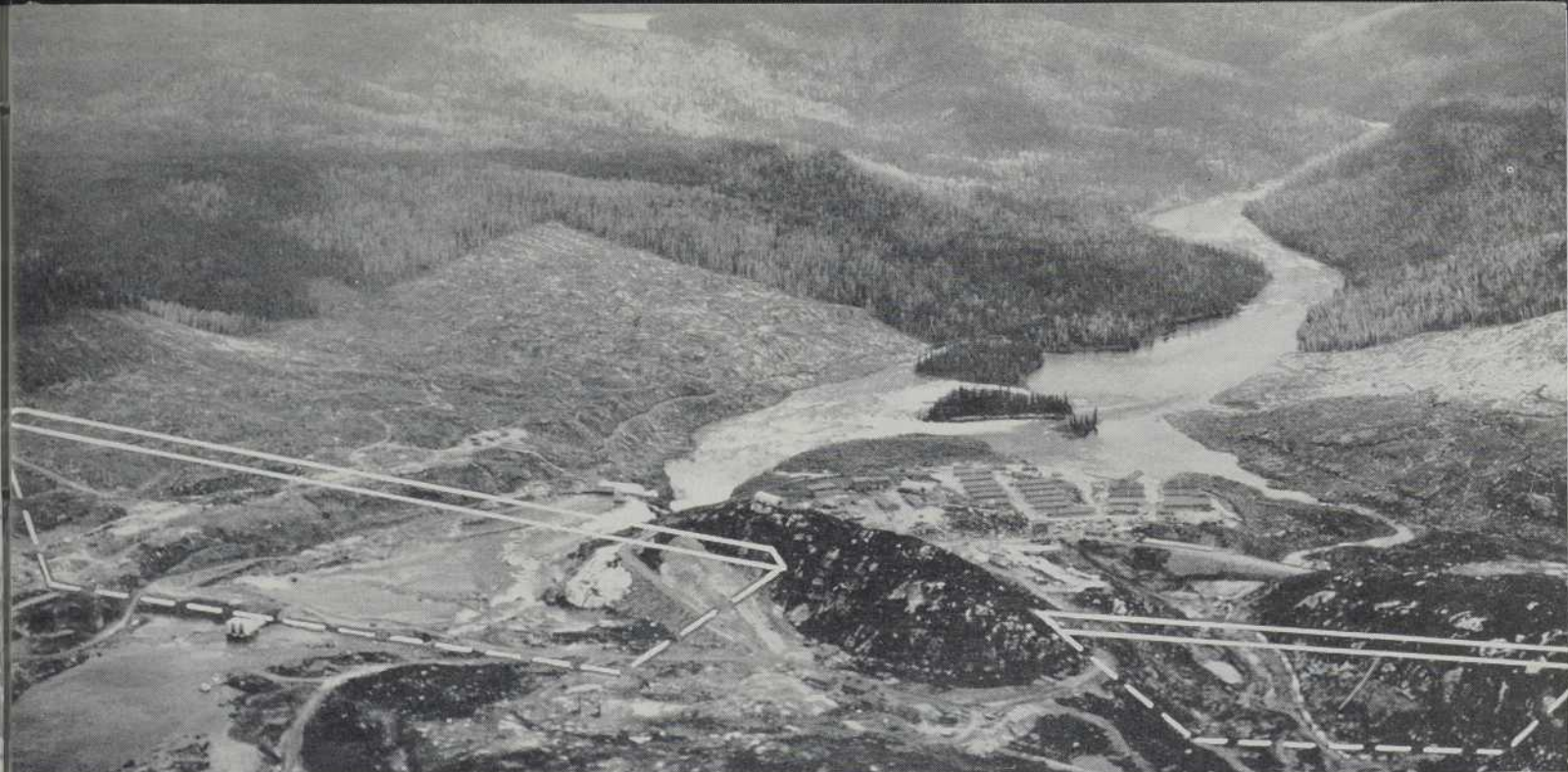
SUR CETTE PHOTO AERIENNE DE LABRIEVILLE ET SES ENVIRONS, UN DESSINATEUR A TRACE L'EMPLACEMENT DES DEUX BARRAGES: BERSIMIS (A DROITE) ET DESROCHES. CETTE VUE A ETE PRISE EN AMONT DES BARRAGES, AU PIED DU LAC CASSE.
