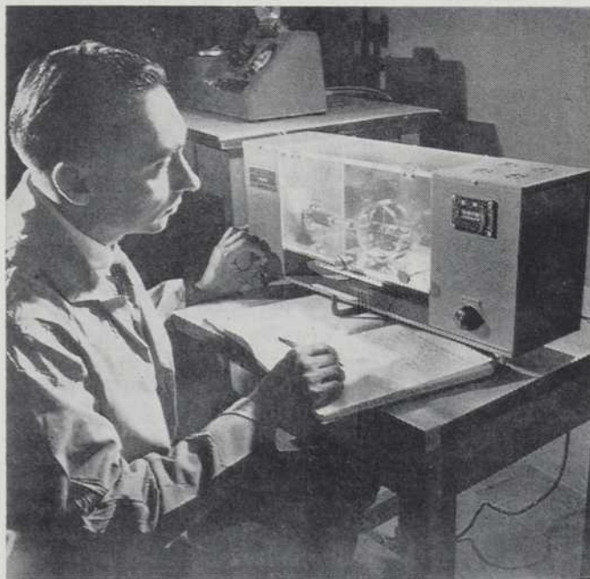
UN CHIMISTE EPROUVE LA DURETE D'UNE PEINTURE A L'AIDE D'UN INSTRUMENT ELECTRONIQUE.
