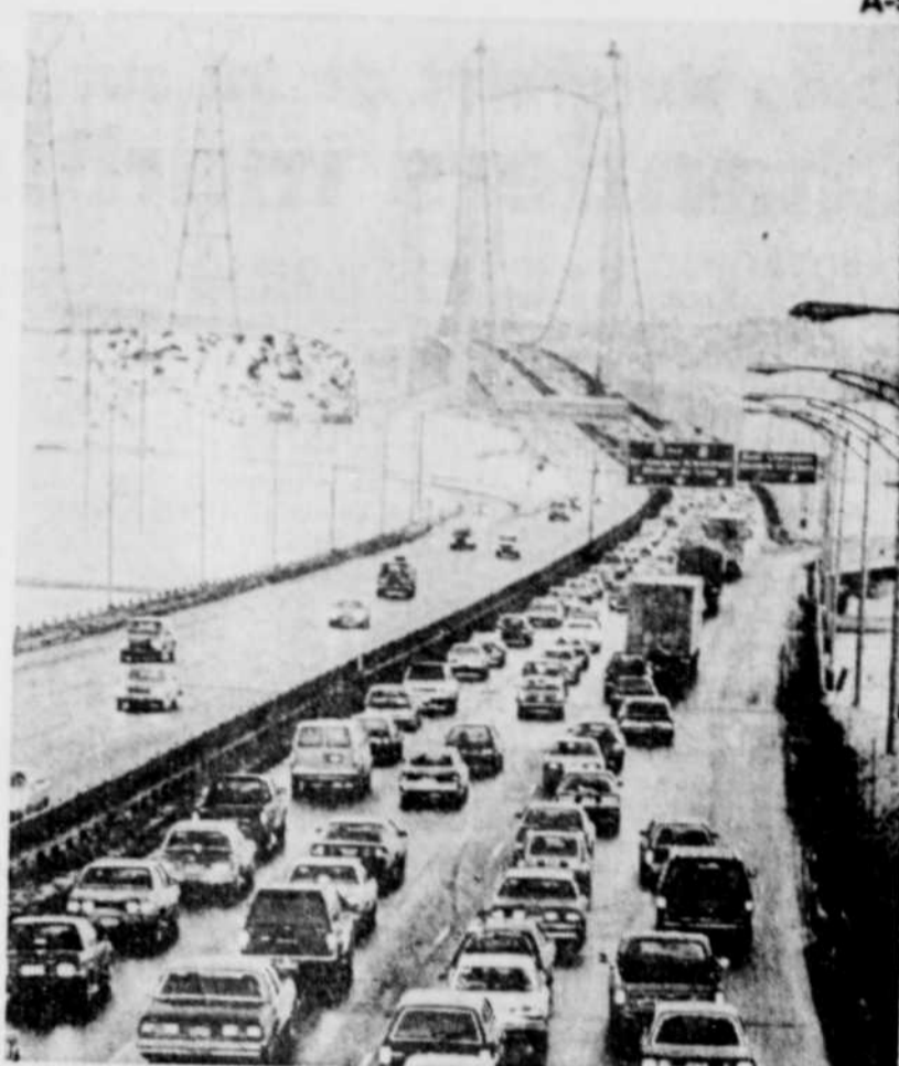
Selon les rapports des spécialistes en circulation routière, le pont Pierre-Laporte n'est pas utilisé au maximum de sa capacité, bien que la fluidité de la circulation soit sensiblement ralentie, matin et soir, aux heures de pointe.
