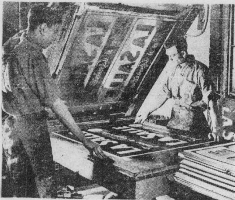
Dans le procédé au profilim, l'écran est alors abaissé sur le profilim, puis fixé à l'aide d'une solution et dépouillé du papier agglutinant.
