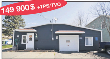
149 900$ +TPS/TVQ Cowansville, rue Albert, Bâtisse commerciale près de 2000 p.c. 2 portes de garage dont une de 12' avec plafond 14'. Plusieurs rénovations effectuées : isolation, fenêtres, plomberie. Terrain de 9000 p.c. Frédéric, Michel ou Kathleen
