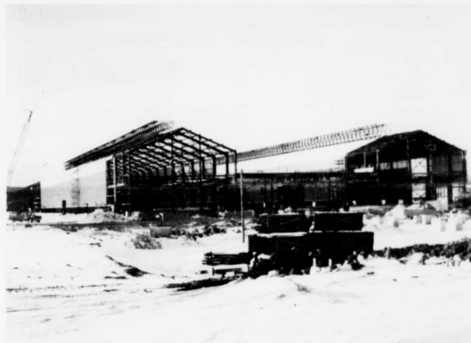
Les travaux de construction de la première phase de l'Usine Grande-Baie se poursuivent normalement. Dès le printemps prochain, l'activité sur le chantier en sera d'autant plus évidente.
