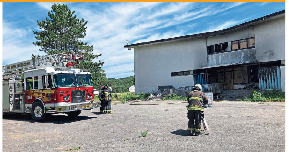
C'est dans ce pavillon, situé sur la rue Saint-Gérard à Saint-Damien, que les pompiers sont intervenus samedi midi. Photo La Voix du Sud - Éric Gourde
