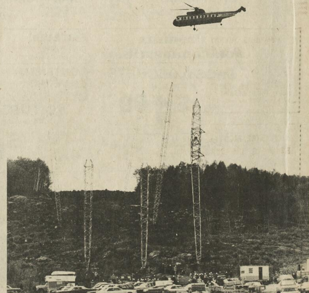
Un hélicoptère d'une capacité de levage de 8,500 livres a été utilisé pour le montage des premiers pylônes à chaînette de la ligne expérimentale construite par l'Hydro-Québec à Sainte-Mélanie, dans les Laurentides. Chaque mât de ces pylônes pèse 8,100 livres. On voit à l'arrière-plan des mâts de pylônes déjà en place; ils seront reliés deux à deux par un assemblage de câbles appelé chaînette.
