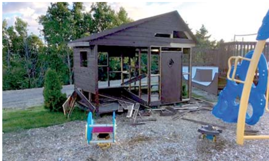
Les vandales s'en sont pris aux structures du terrain de jeux.
