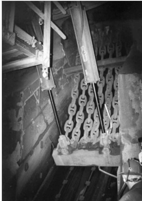
Figure 3.2. Chaînes de contrôle avec murs latéraux et glissière d'acier.
