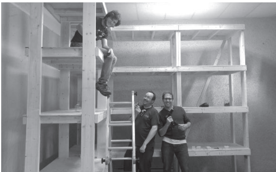
Les bénévoles et les chefs de ce groupe scout travaillent à compléter la structure qui servira à entreposer le matériel de camping et de jeu. Crédit photo : Isabelle Lessard
