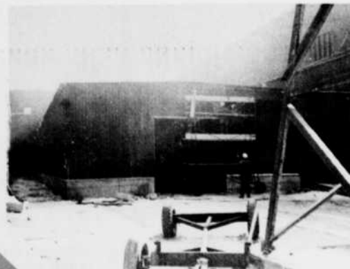
Un entrepôt rajéuni
