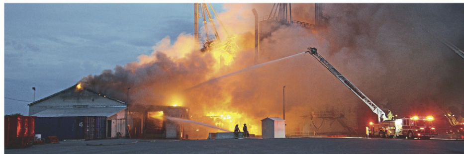
Le feu a complètement détruit les installations de la Meunerie Robitaille. (Photo: gracieuseté - Patrick Taillon)
