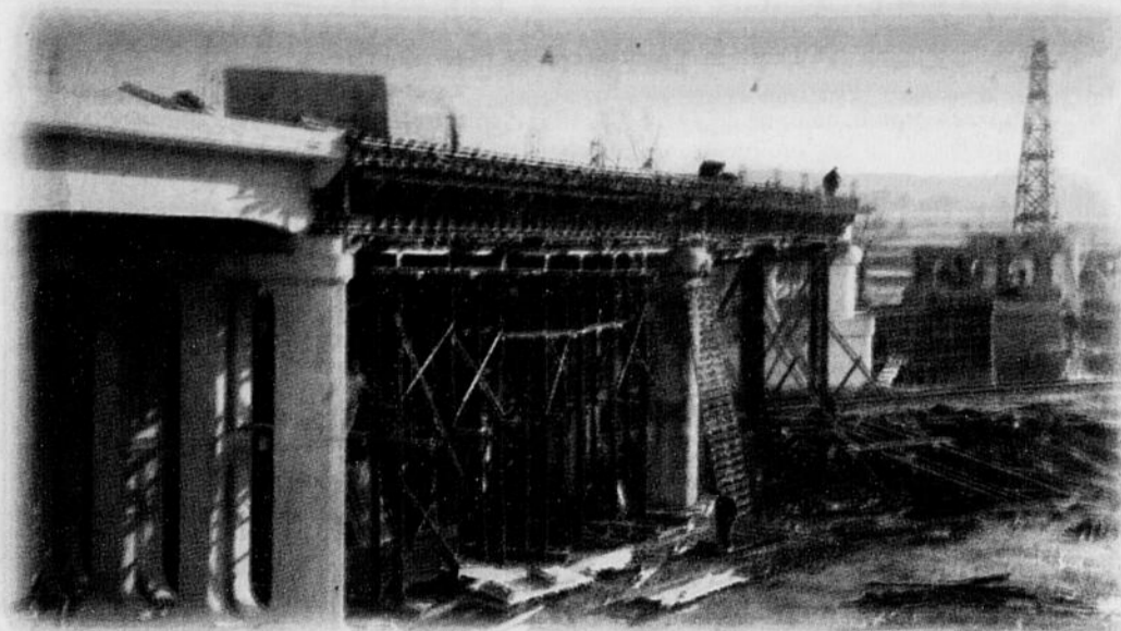
La Construction du pont Comstock (1938) au-dessus de la rivière Massawippi, à la limite sud de Lennoxville, sur la route 143 vers Stanstead.
