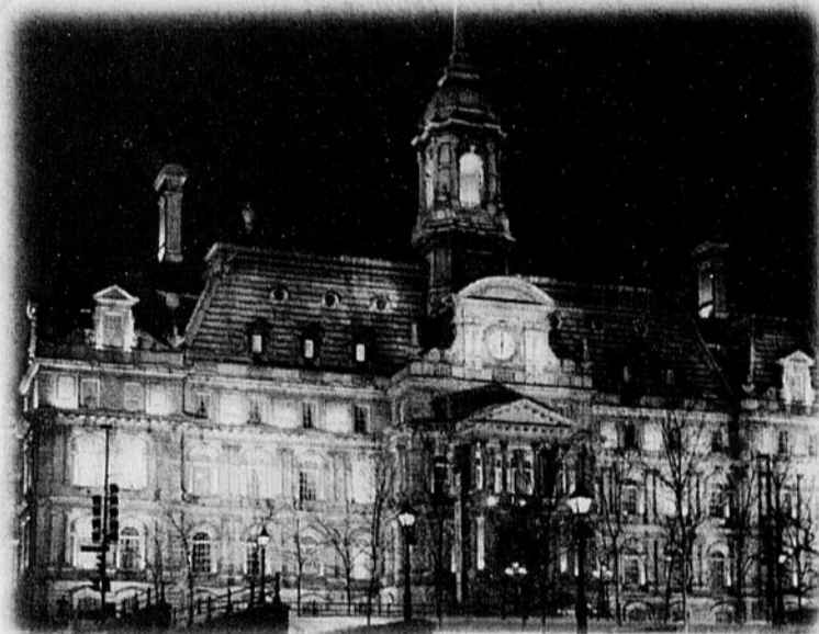
À l'Hôtel de ville de Montréal, le Groupe Teknika a réalisé des travaux d'éclairage architectural.
