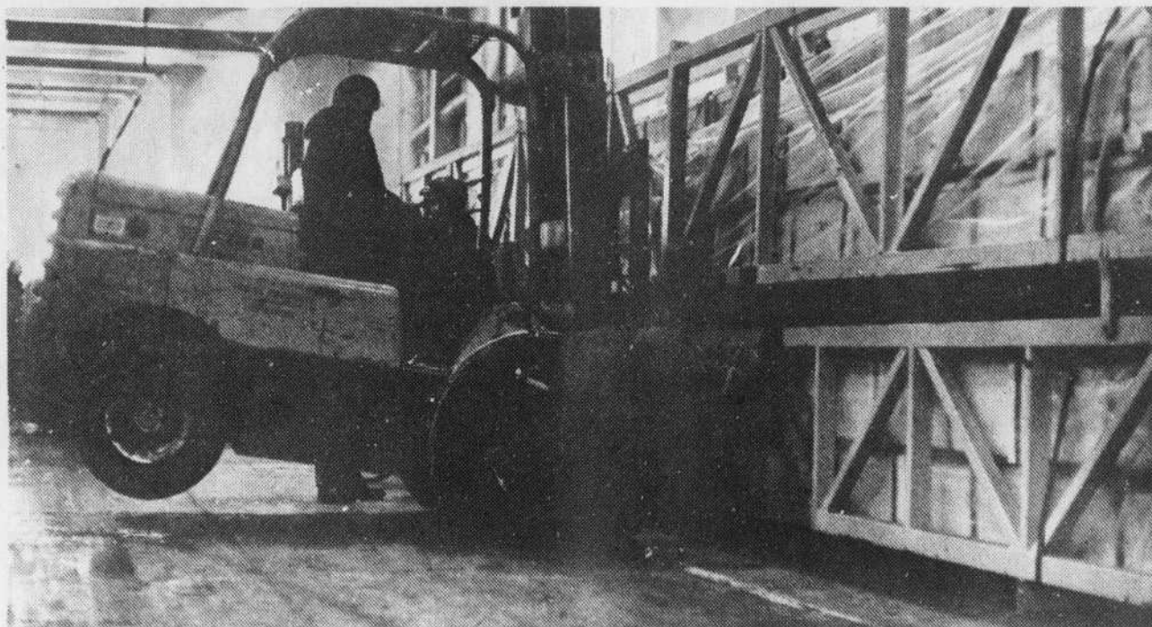
L'Hydro-Québec vient d'accuser réception des tubes de générateurs de vapeur les plus longs jamais expédiés au Canada. Ces pièces sont destinées à la centrale nucléaire de Gentilly 2. Fabriqués en Suède, les tubes sont faits d'un alliage de fer, nickel et chrome et doivent durer au moins trente ans.
