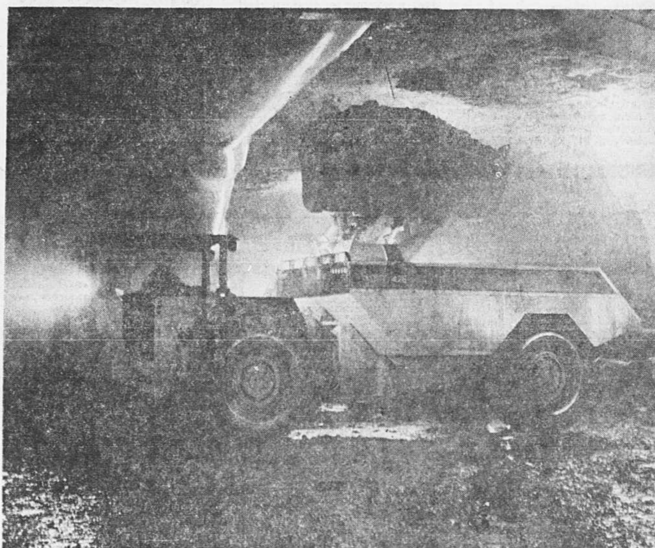
Ces camions surbaissés ont été fabriqués spécialement pour les travaux du métro de Montréal, au coût de $100,000 chacun. D'une capacité de 26.000 tonnes, ils transportent les débris de roc jusqu'au puits central, seul accès aux couloirs durant la construction.
