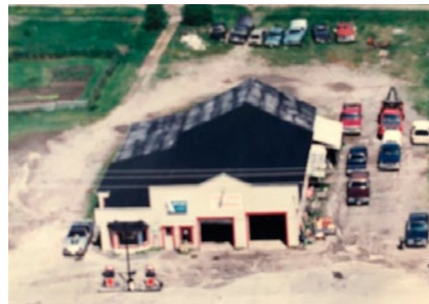
Vue aérienne du Garage Central Crédit photo : National Air Photo
