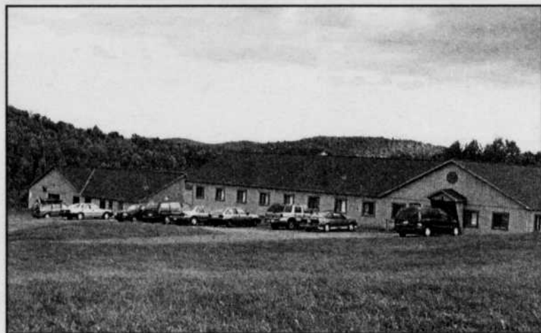
La base de plein air Davignon.
