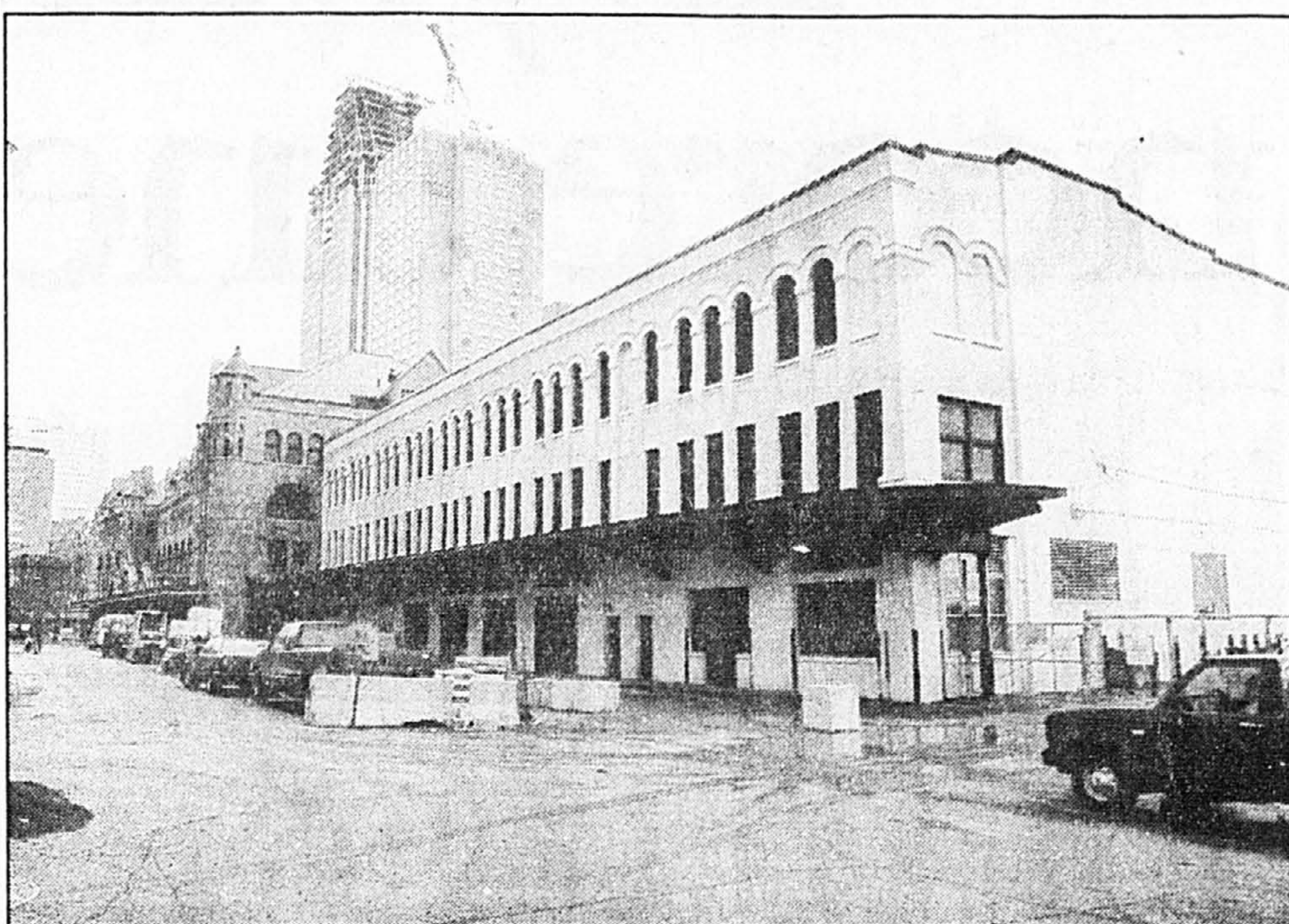
La «hutte de boue» pourra être démolie mais pas obligatoirement. Une façon de cautionner sa disparition...
