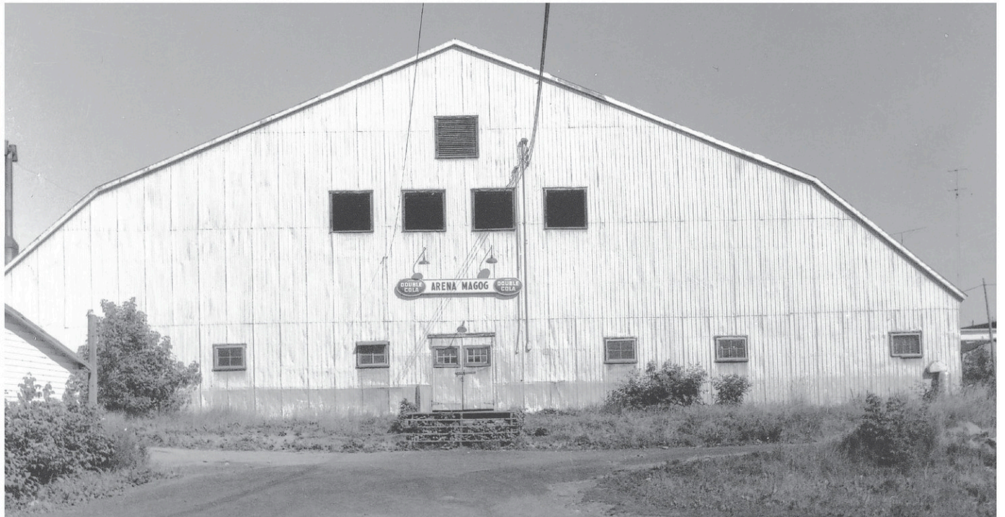
L'aréna «de tôle» de la rue Sherbrooke est condamné par les inspecteurs d'assurance en 1963. (Source : Société d'histoire de Magog, Fonds Studio R.C.)
