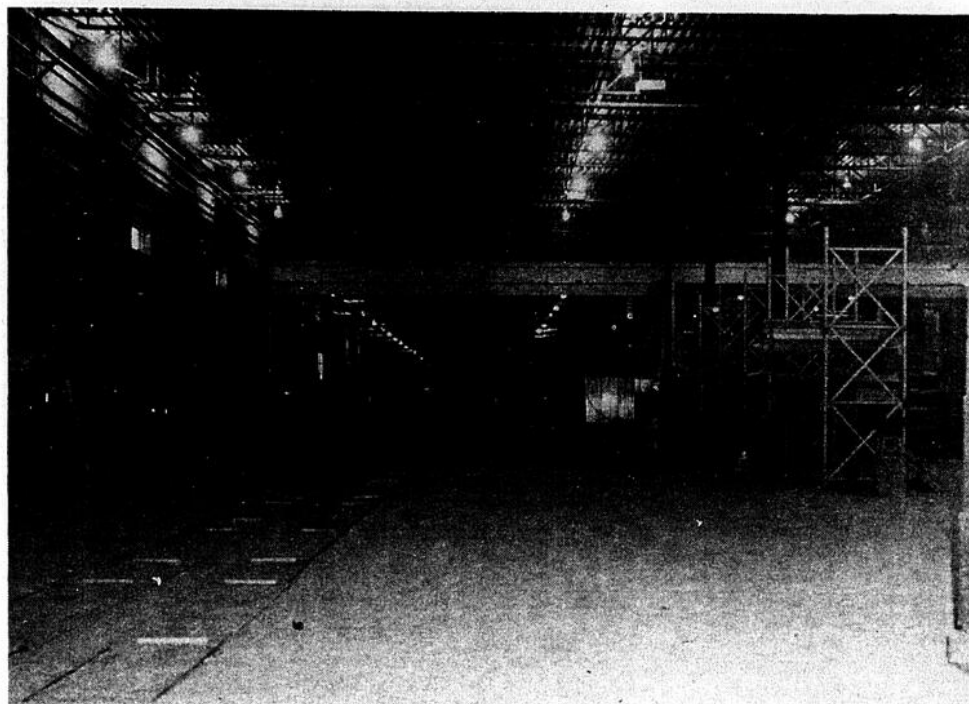
Nous avons ici une vue intérieure des aménagements effectués aux Industries L'Islet. La nouvelle partie rejoint le bâtiment de montage au niveau de l'énorme poutre que nous apercevons à l'arrière-plan. (R.L.— PEUPLE—COURRIER)
