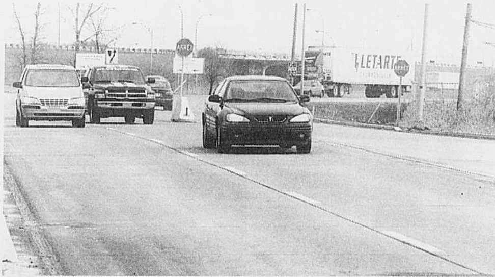
Le chemin du Tremblay s'est refait une beauté... en béton, un fait très rare pour une route urbaine au Québec (photo: Alain Roberge/PPM)
