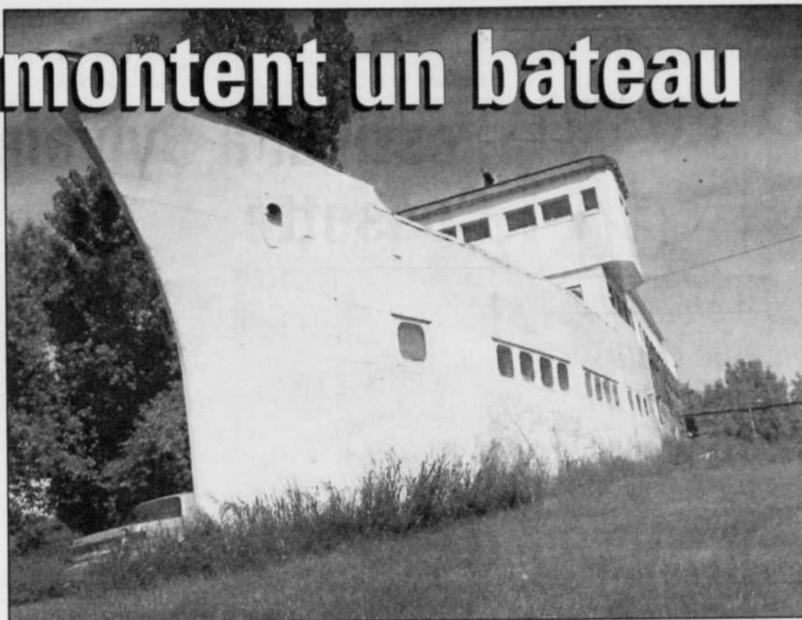
Le bateau d'une longueur de 33 mètres a été construit avec des planches récupérées dans de vieilles granges. Le coût total du bateau-maison ne dépasse guère 10 000 $.
