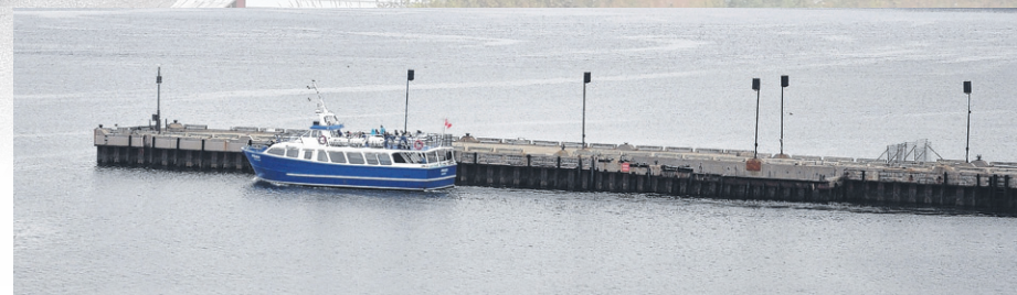
Au niveau du quai, Félix Caron précise qu'il y a présentement des discussions/négociations entre les gouvernements du Québec et du Canada à ce sujet. « Les sons de cloche que j'ai présentement, c'est que les discussions vont bien. Les travaux pourraient se faire plus vite qu'on le pense... » (Photo Alain Lavoie)
