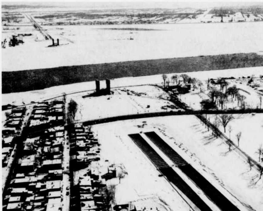
Vue d'ensemble du pont-tunnel à partir de la rive nord
