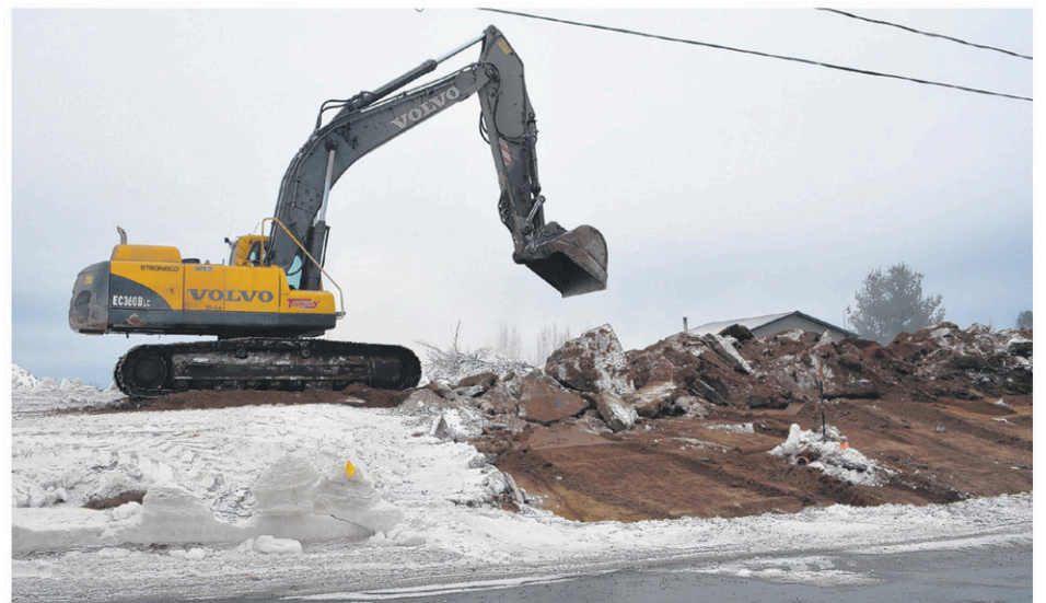
Les travaux de construction du bâtiment de la nouvelle clinique médicale, qui abritera aussi la pharmacie, se sont amorcés au cours des derniers jours. (Photo TC Media - Carol Isabel)
