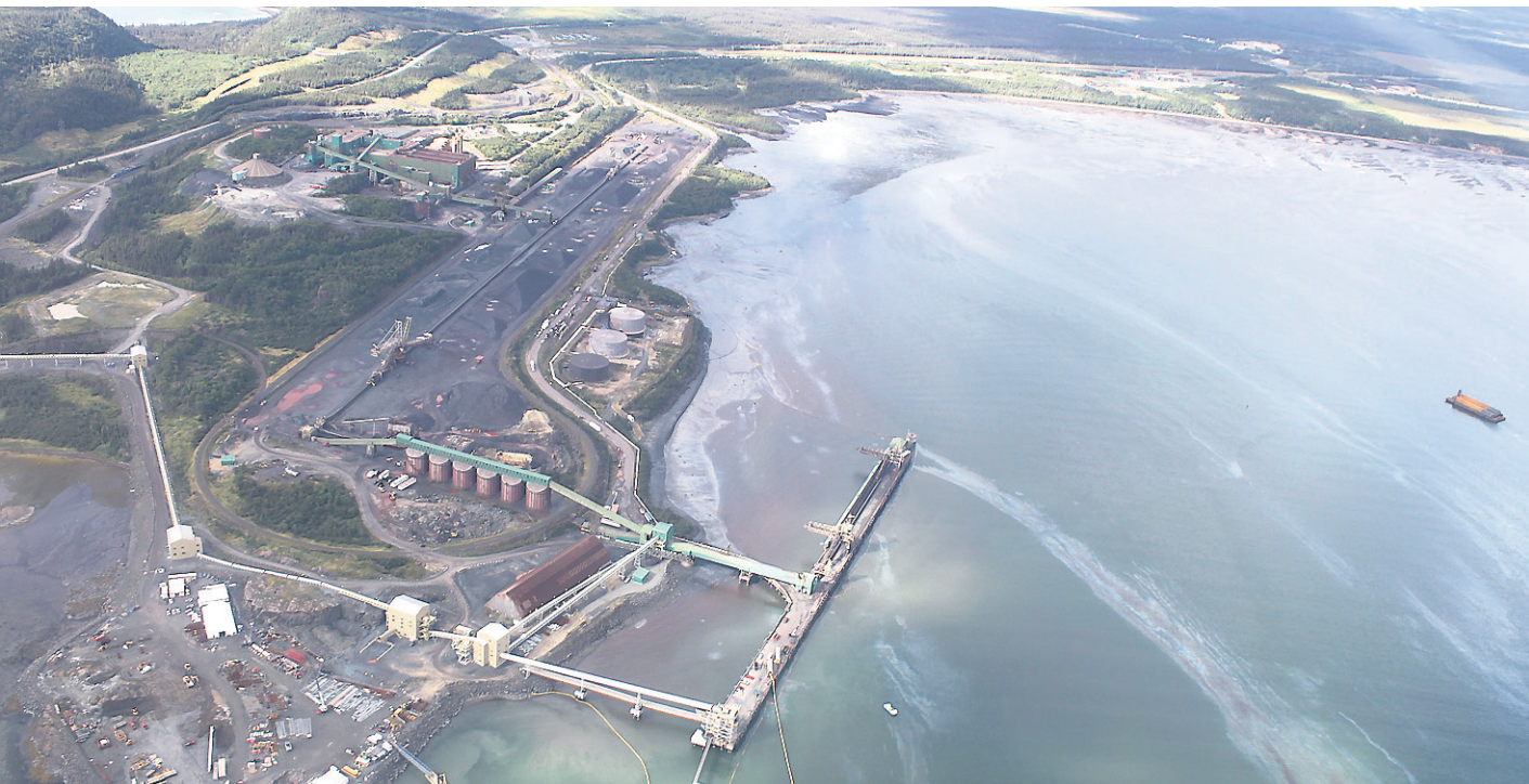
La vue aérienne des installations de Cliffs Natural Resources laisse croire que les hydrocarbures se sont répandus sur plusieurs dizaines de mètres.
