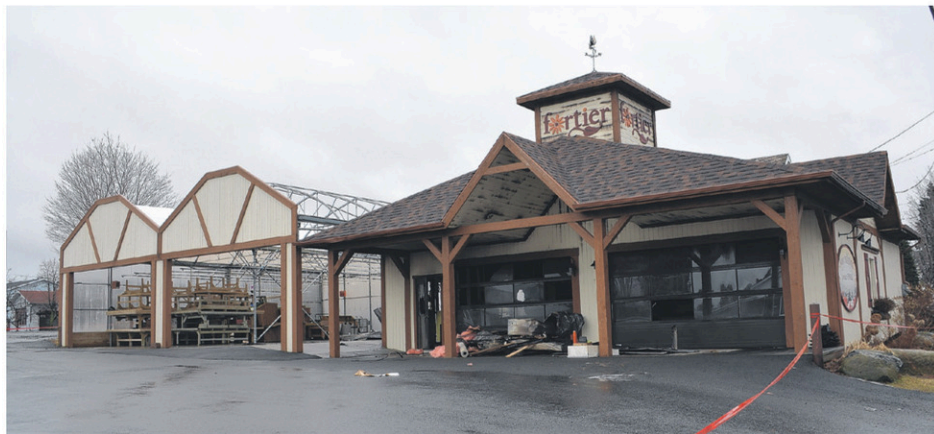
Des dommages importants ont été causés. (Photo TC Media – Carol Isabel)
