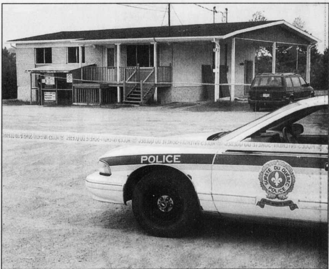
Un ou des voleurs ont défoncé le mur d'un logement pour arriver, dans la nuit de mercredi à hier, directement dans la voûte de la caisse populaire de Stoke, située dans un immeuble abritant en plus trois locyers.
