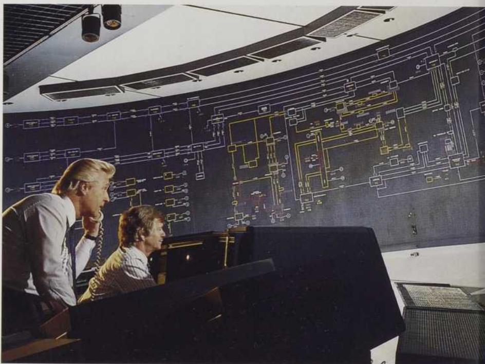
La carte informatisée du Centre de conduite du réseau d'Hydro-Québec donne une vue d'ensemble en temps réel de tout le réseau hydro-électrique. Les répartiteurs y font la gestion de la production et du transport de l'électricité, de même que des échanges avec les réseaux voisins.
