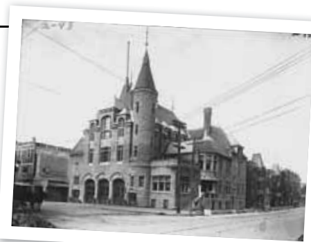
La caserne de pompiers n° 30, anciennement l'hôtel de ville de Saint-Louis, située à l'angle de la rue Laurier Ouest et du boulevard Saint-Laurent.
