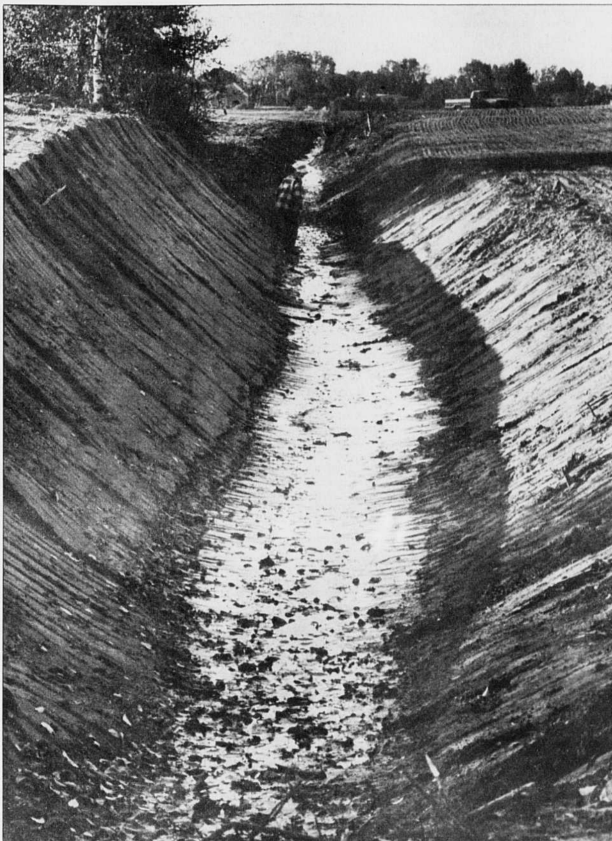
Le ruisseau Gauthier, à Contrecoeur, reprofilé au cours de l'été dans le cadre du programme Sol-Plus. Quelque 20 000 km de cours d'eau ont été ainsi artificialisés au Québec sans qu'on mesure les impacts environnementaux de cette opération.
