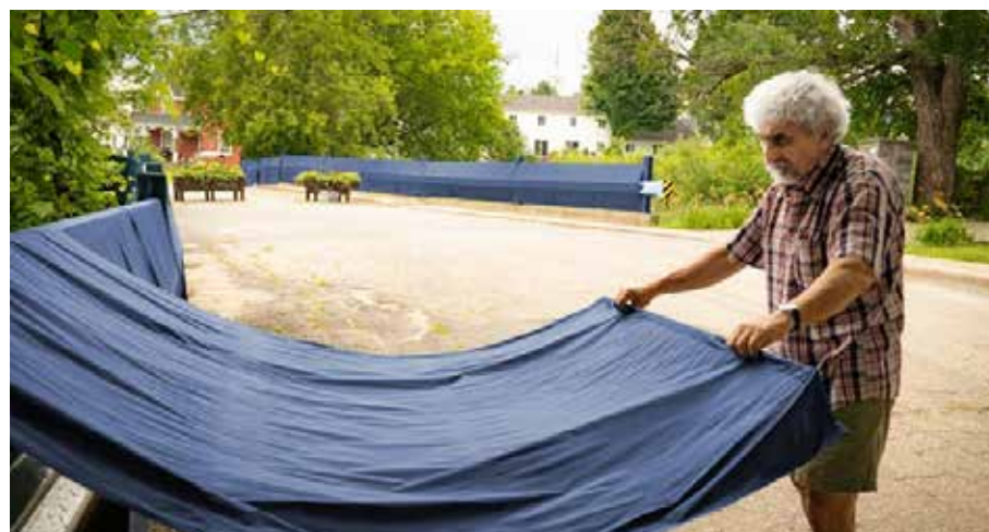
Özgen Eryaşa installe un panneau de tissu bleu sur l'une des sections du pont Duquette. Crédit photo : Carl Bernier
