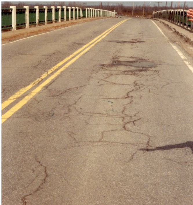
Photo 3.7.1 f) – Fissures polygonales très importantes
