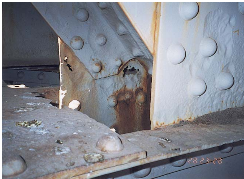
Photo 9.3.3 o) – Assemblage d'une poutre triangulée
