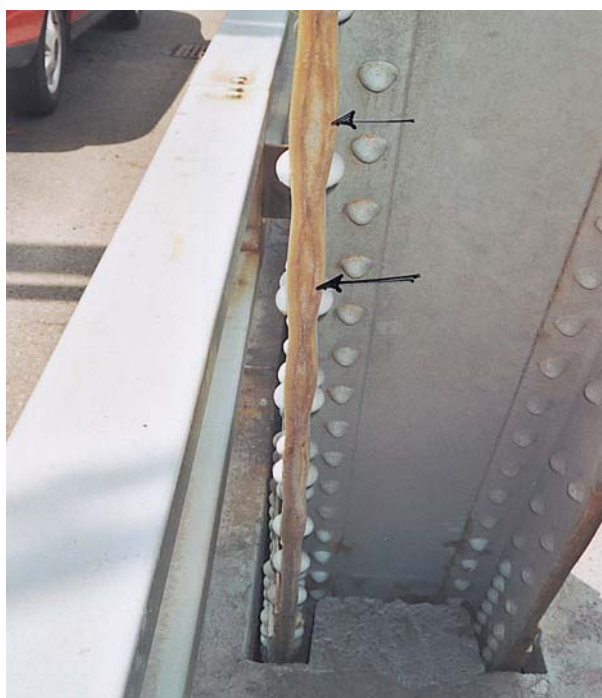
Photo 9.3.3 p) – Diagonale d'une poutre triangulée
