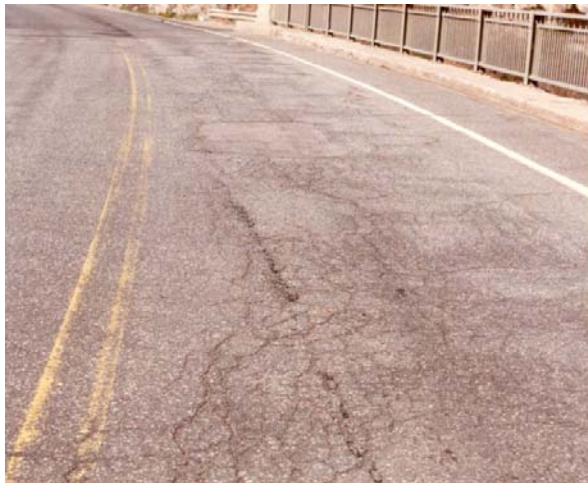
Photo 10.4.3 b) – Surface de roulement en enrobé bitumineux
