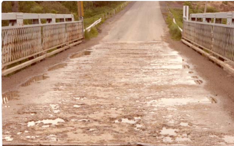
Photo 10.4.3 a) – Surface de roulement en béton de ciment
