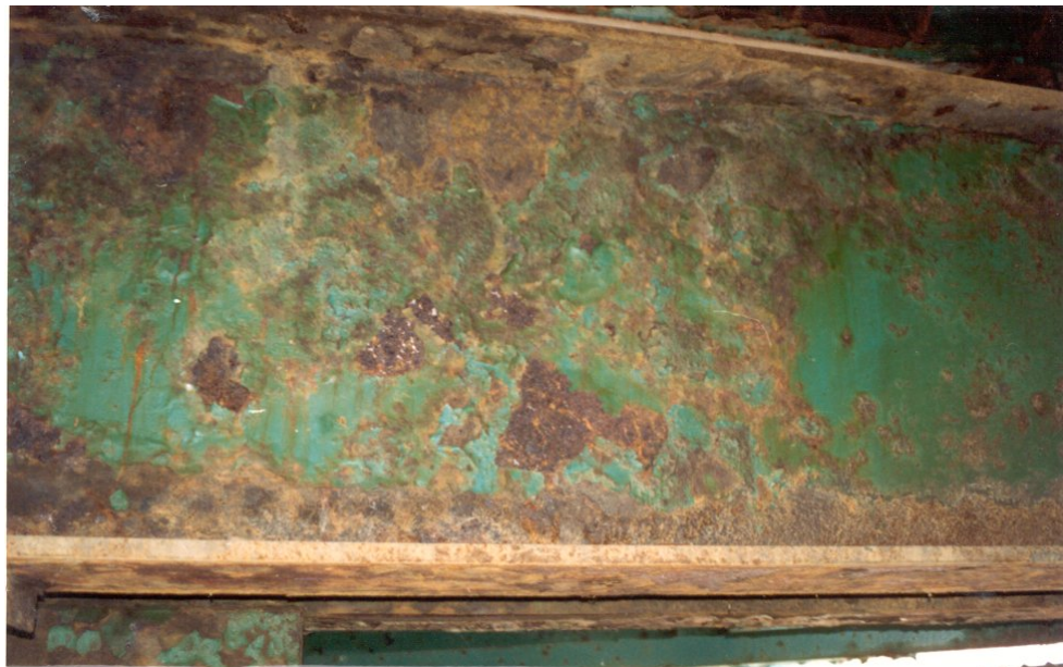
Photo 9.3.3 j) – Extrémité d'une poutre en acier
