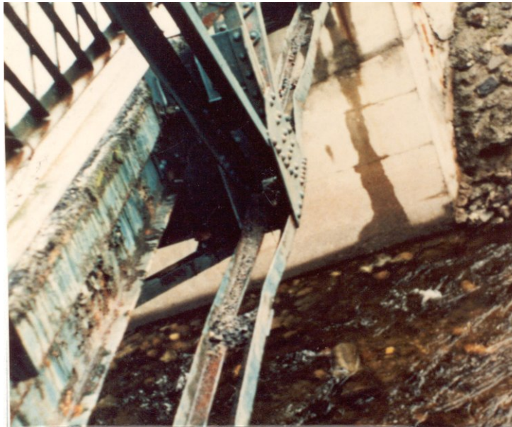
Photo 9.3.3 m) – Membrane inférieure d'une poutre triangulée
