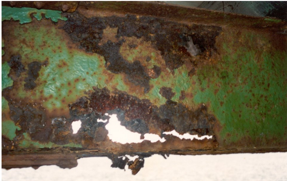
Photo 9.3.3 i) – Centre d'une poutre en acier
