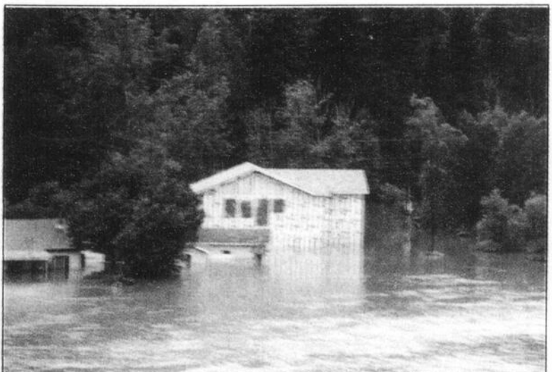
PAS CHANCEUX - La construction de cette maison dans le secteur du Portage à Laterrière était presque complétée. Malheureusement, la crue des eaux est venu gâcher le rêve de ce propriétaire. Pour les autres, c'est aussi le cauchemar.
