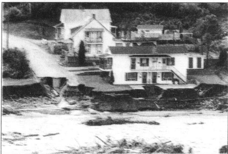
EROSION - La forte montée des eaux de la rivière Ha! Ha! dans le secteur St-Alexis à Ville de La Baie a complètement grugé la rue de la Rivière. Cette route menait à Ferland-Boilleau. L'eau a aussi grugé l'infrastructure de la rue Thomas-Lalancette.
