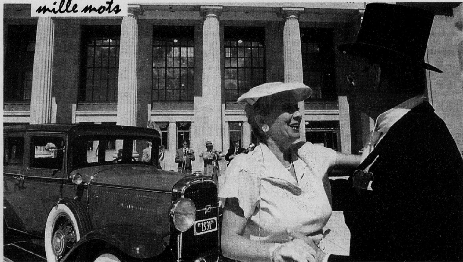
La gare Jean-Talon a, hier, repris sa place dans l'histoire du quartier montréalais Parc Extension. Cette réouverture est accompagnée de l'inauguration du cinquième supermarché Loblaw's de la région métropolitaine. Le rez-de-chaussée de la gare communique directement avec le supermarché et le stationnement intérieur de près de 300 places.
