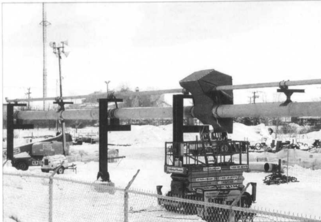
Cette conduite et une autre semblable sont en train d'être mises en place dans le but d'acheminer la vapeur aux usines de Norsk Hydro et de PCI Chimie Canada lorsque la centrale de cogénération sera mise en service, à la fin de l'été.
