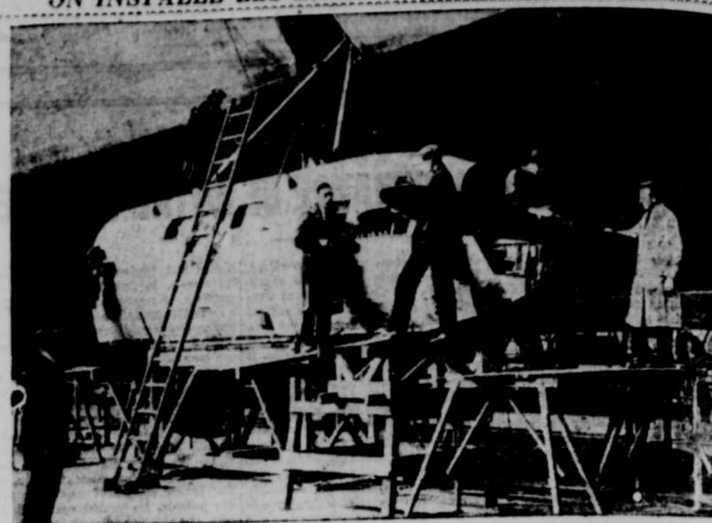
Cette vignette nous montre des mécaniciens installant une puissante hélice aux engins Rolls-Royce du R-100, la plus grosse dirigeable jamais construit. Ce dirigeable fera sa première envolée de la Grande Bretagne au Canada.
