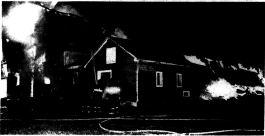
En plus de son bâtiment de ferme, monsieur Robert Dubé a perdu 30 000 balles de foin, 125 tonnes de grain ainsi que quelques génisses et un taureau.
