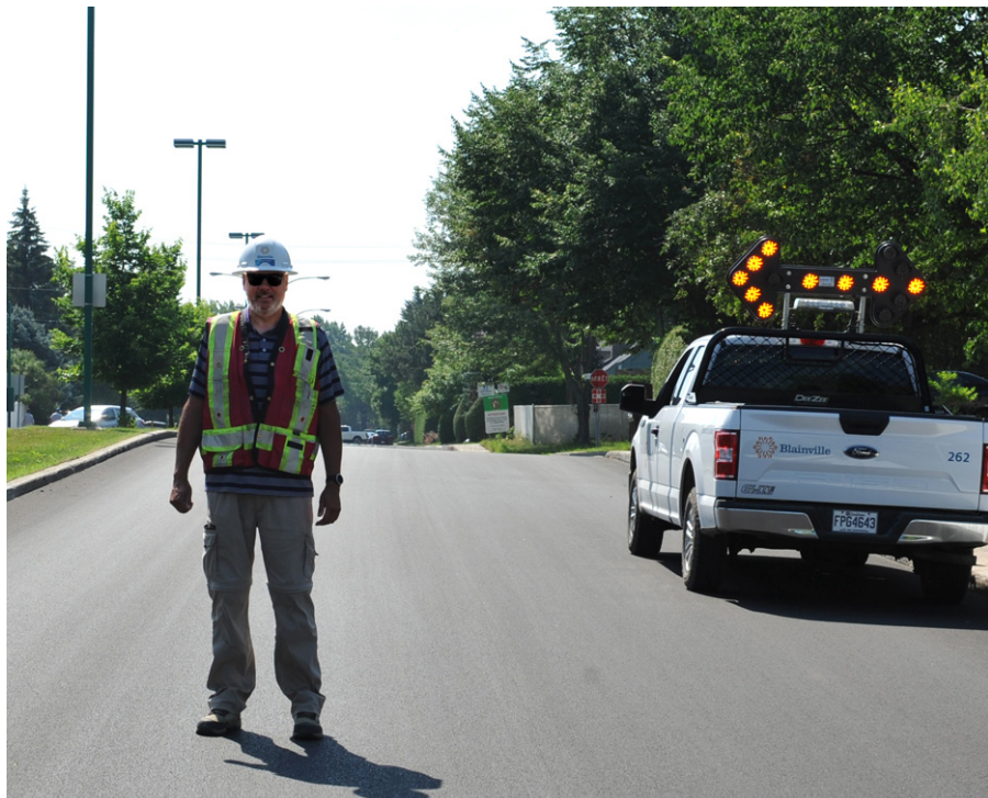
Janick Lepage (technologue - Service du génie) sur le boulevard Jacques-St-André dont la réfection a été complétée au mois de juin.
