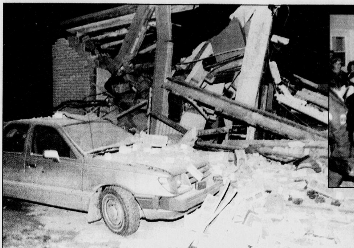
Bien qu'ils aient été faits de béton doublé de brique, les murs du garage Lucien Perreault et Fils ont été complètement soufflés par l'explosion.
