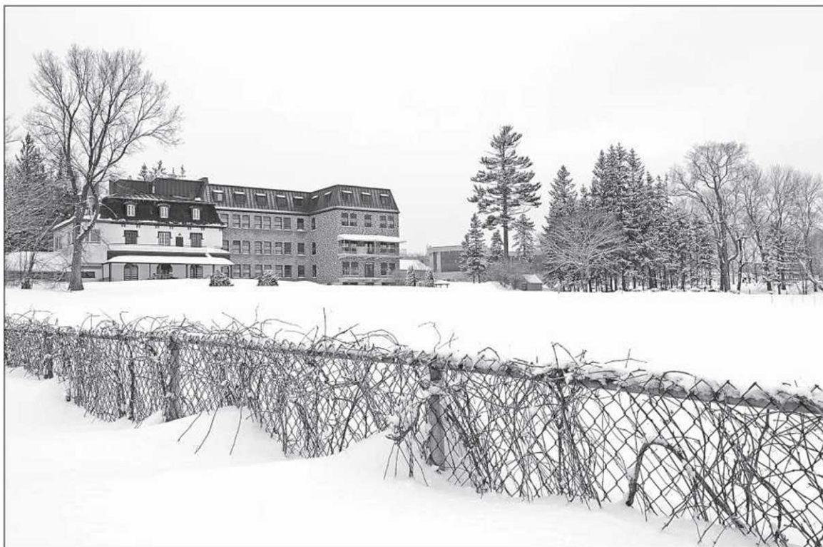
Les vastes domaines aménagés au XVIII e siècle par les barons du bois, qui surveillaient leurs chantiers du haut de la falaise, ont été transmis à des communautés religieuses comme, ci-dessus, les Sœurs d'Afrique, qui les ont perpétués jusqu'à aujourd'hui. — PHOTOTHÈQUE LE SOLEIL, PATRICE LAROCHE
