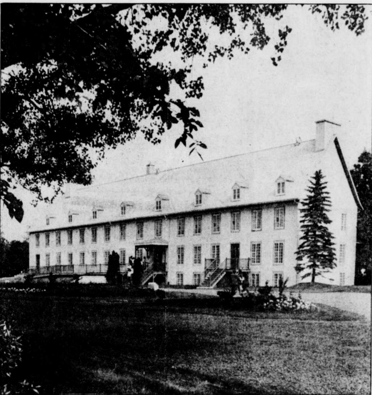
L'édifice historique du Domaine Maizerets a fait l'objet de travaux de rénovation majeurs ces dernières années.
