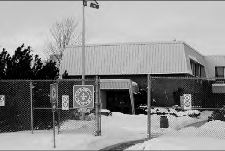
Le poste sera situé sur le boulevard de la Salette à St-Jérôme, à même le poste autoroutier, au deuxième étage.
